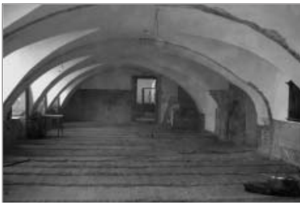
Der ehemalige Gasthof Hochhuber in der Umbauphase.
